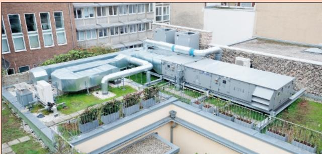
Über 182 Drallaussäusen wird die Frischluft im Zuschauer- raum bodennah im Stuhlbeinbereich zugeführt und im Deckenbereich abgesaugt. Dadurch ist in den Bereichen, in denen sich Personen aufhalten, immer Frischluft vorhanden. Auf der Bühne und im Foyer
