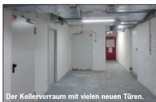
Der Kellervorraum mit vielen neuen Türen.
